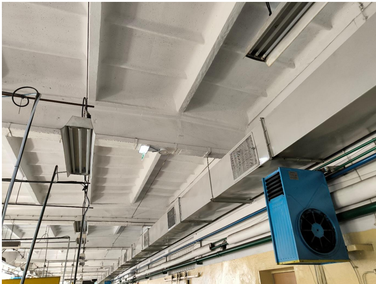
Rysunek 3 Ustrój nośny budynku – widoczne słupy, dźwigar, płyty korytkowe (DKZ)
